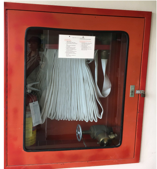
ภาพที่ 1-13 ตู้หัวฉีดน้ำดับเพลิง
