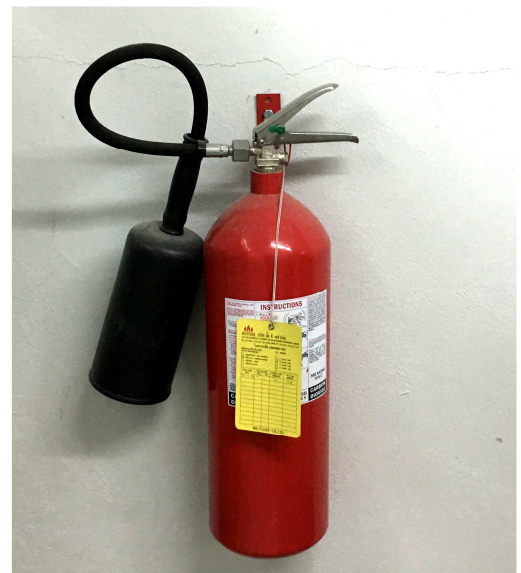
ภาพที่ 1-15 ถังดับเพลิงแบบมือถือ
